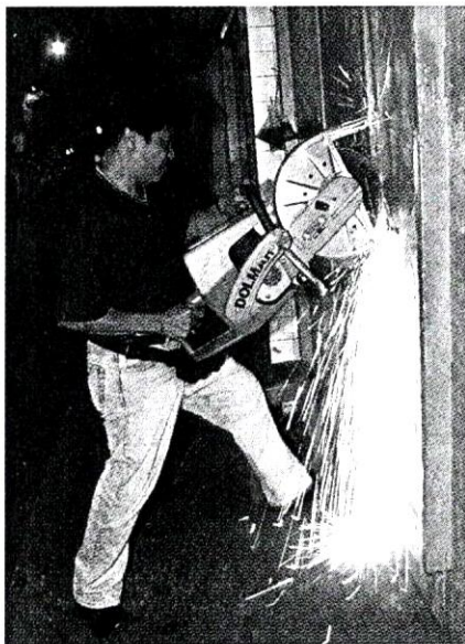
Pintu yang dikunci dipecahkan menggunakan gergaji bermotor.
