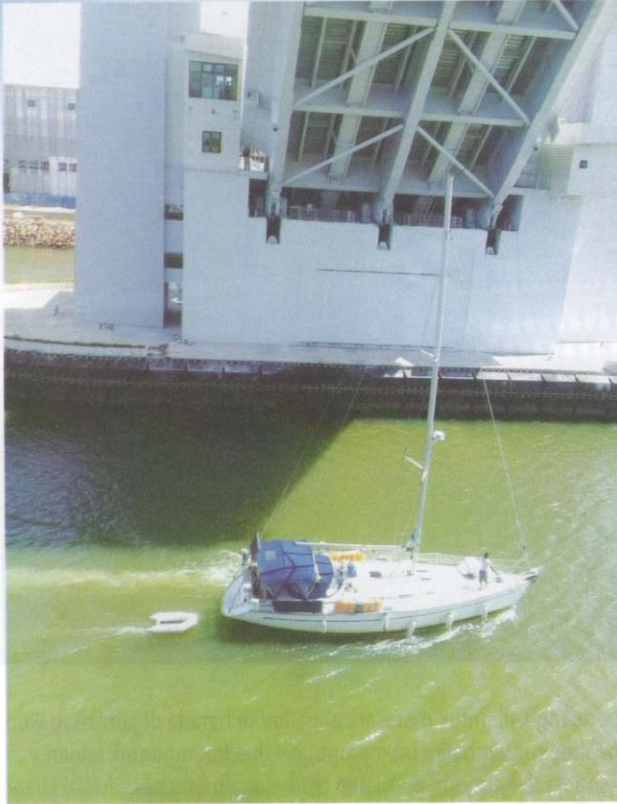
Jambatan Angkat Kuala Terengganu dilengkapi dengan sistem hidraulik bascule yang membolehkan kapal besar melalui bawahnya.
