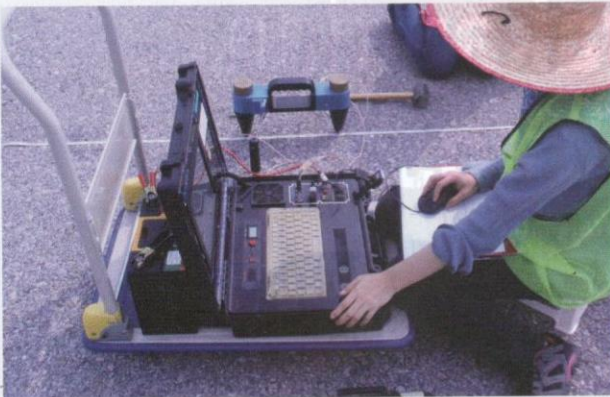
Proses pengukuran di lapangan menggunakan kaedah SASW.
