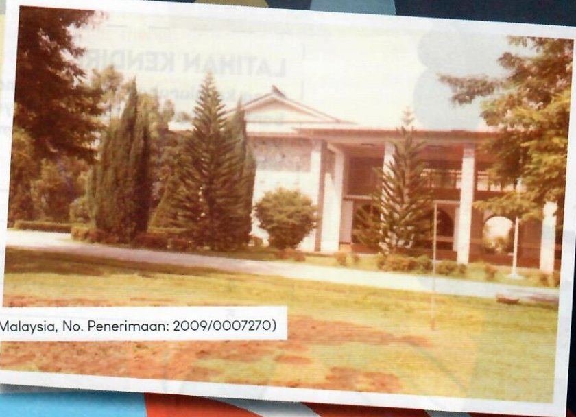
Bangunan Sri Taman pada tahun 1982.
