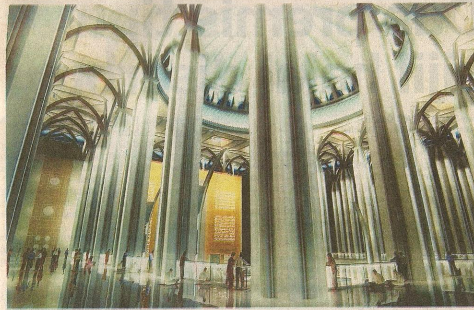
RUANG solat memperlihatkan tiang-tiang besi keluli adalah sokongan utama binaan masjid manakala kubah disiapkan sepenuhnya menggunakan keluli tahan karat.
