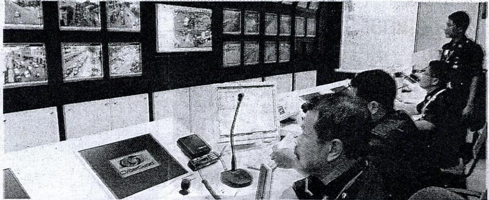
PANTAU... anggota di Bilik Gerakan Polis di Pulau Pinang mengawasi CCTV polis yang dipasang di sekitar Georgetown.
