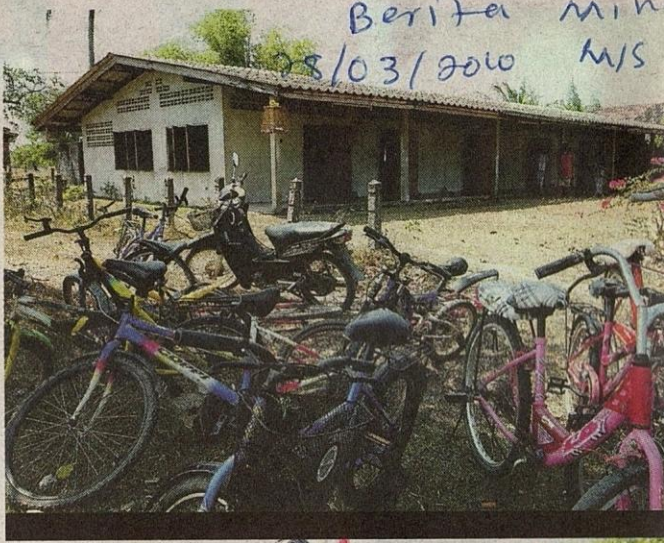
Bangunan sekolah agama yang dibina semula selepas musnah akibat tsunami di Ban Muang Kluang.
