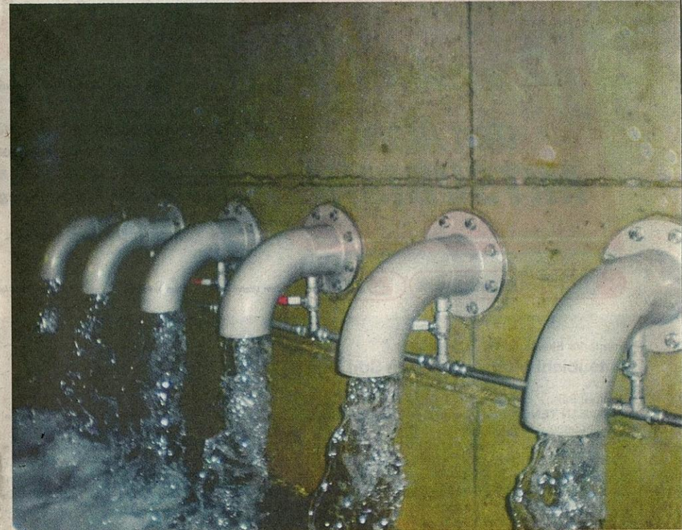
AIR tanah yang dikeluarkan tanpa pam melalui sistem telaga condong di Loji Air Yverdon, Switzerland di mana air dibekalkan terus kepada pengguna tanpa rawatan.
