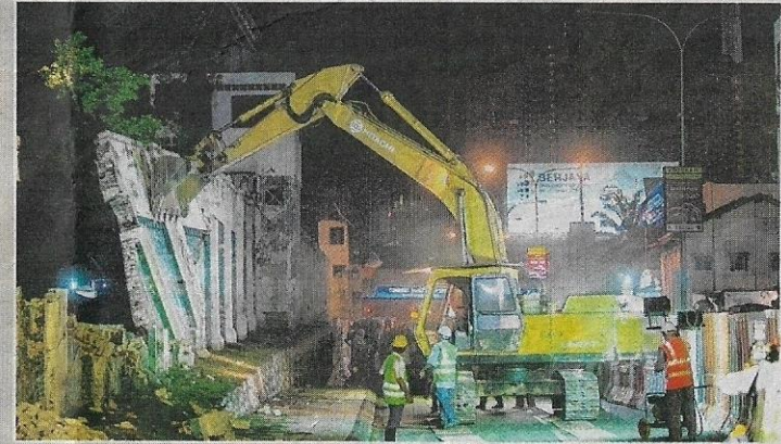
KERJA-kerja merobohkan tembok Penjara Pudu menggunakan dua buah jentolak bermula Isnin lalu.
