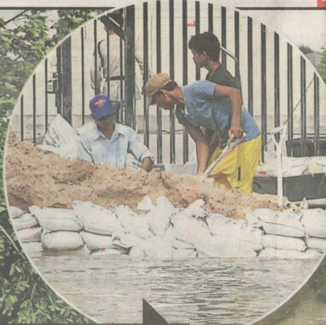
Pekerja membina benteng air selepas banjir mengancam kilang di kawasan perindustrian Amata Nakorn di wilayah Chonburi, timur Thailand. [FOTO AP]
