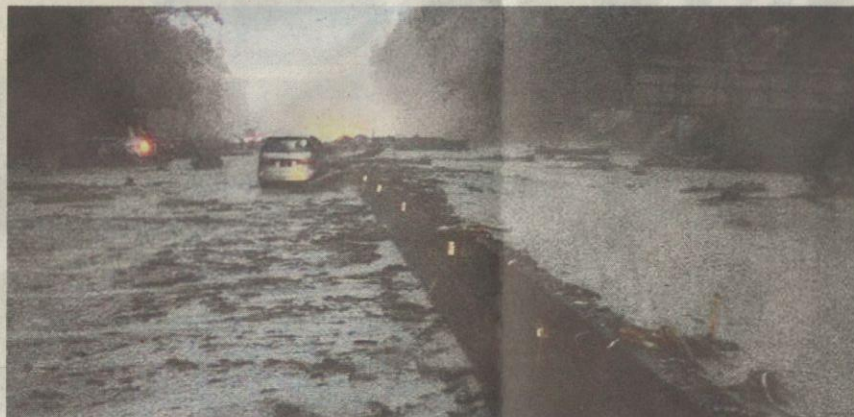
KEADAAN di lokasi kejadian tanah runtuh di Kilometer 52.4 Lebuhraya Kuala Lumpur-Karak.
