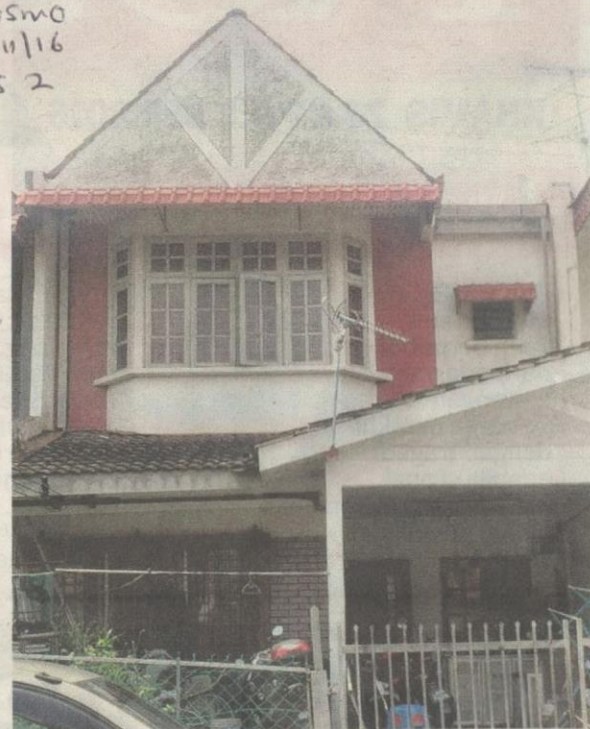
RUMAH dua tingkat di Taman Ehsan Jaya, Desa Cemerlang di Johor Bharu, tempat dua beranak bergaduh sehingga seorang daripada mereka mati.
