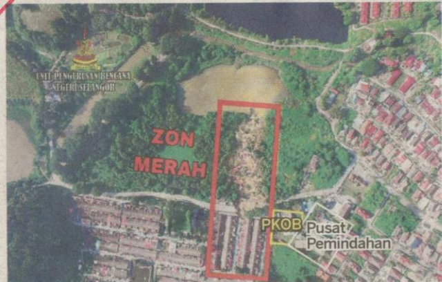
LOKASI kejadian tanah runtuh yang diwartakan sebagai Zon Merah di Taman Idaman, Serendah, Hulu Selangor semalam.
