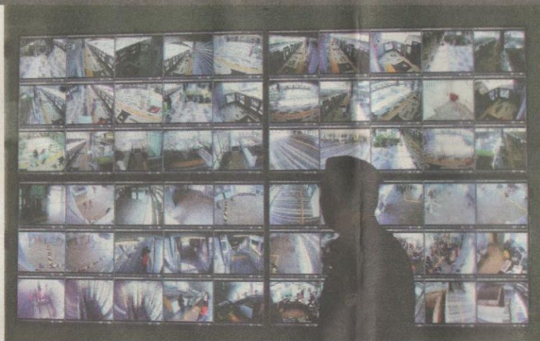
BILIK pemantauan bagi memastikan tren beroperasi dengan baik selain meningkatkan tahap keselamatan penumpang.
