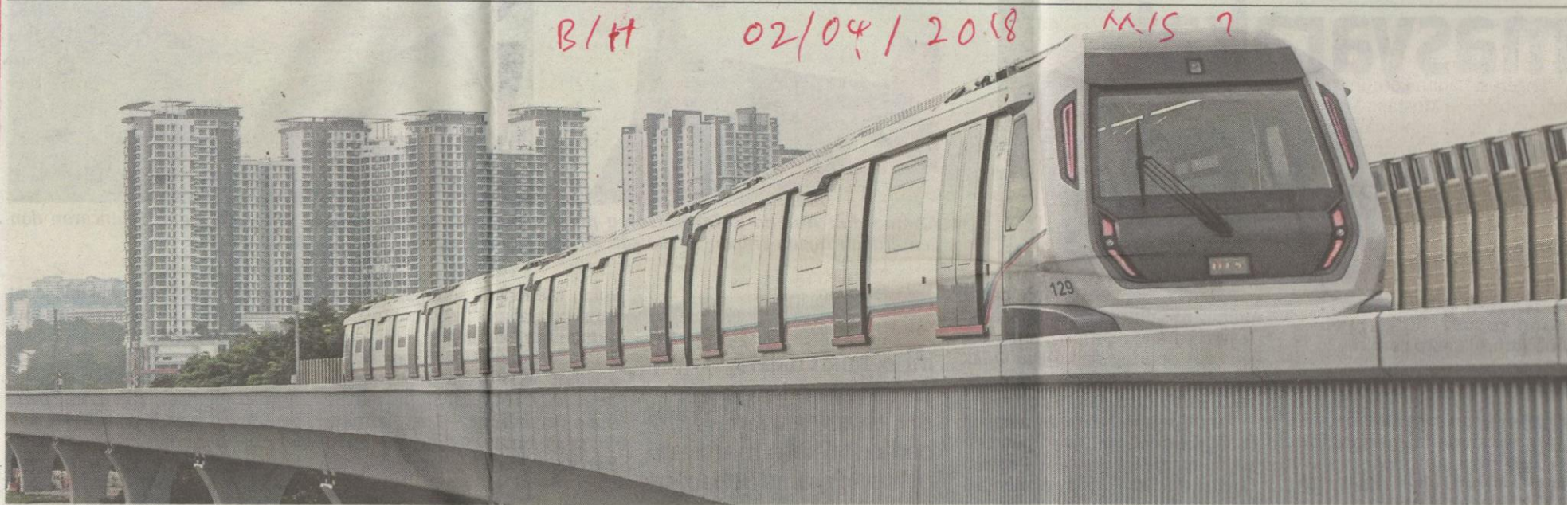
Transit Aliran Massa antara pembangunan mega pengangkutan awam dilaksana kerajaan.
