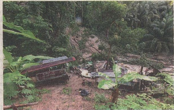
Kawasan kejadian tanah runtuh menghempap sebuah rumah setinggalan yang didiami satu keluarga di Taman Elok, Jalan Bukit Nenas.
