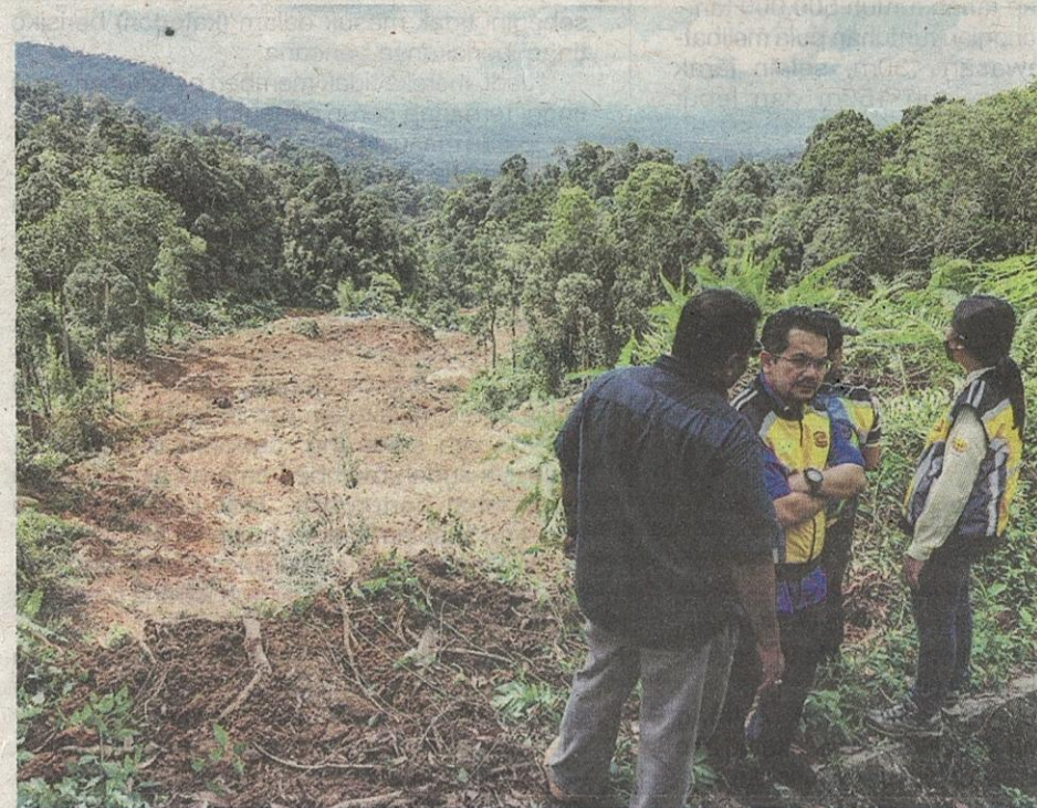
Keadaan tanah runtuh berhampiran tapak perkhemahan di Father's Organic Farm, Batang Kali, Hulu Selangor pada Jumaat.
