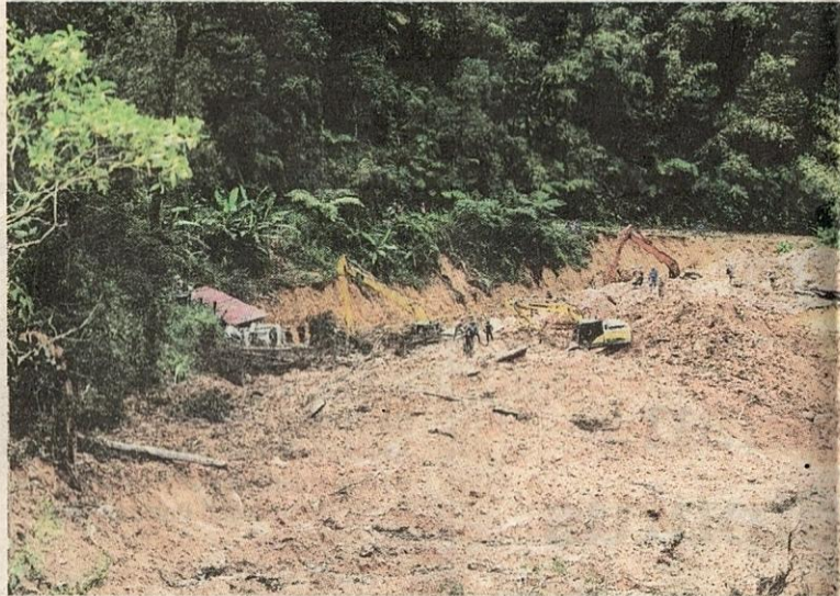
LOKASI kejadian tanah runtuh yang mengorbankan 31 mangsa di Batang Kali, Hulu Selangor. – SHIDDIEQIIN ZON
