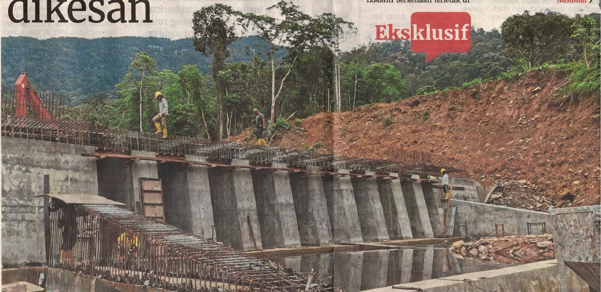
Struktur Sabo yang dalam pembinaan di Titi Hayun, Gunung Jerai, Kedah mampu menghalang serpihan, batu dan kayu yang dibawa bersama arus deras jika berlaku kejadian kepala air.
