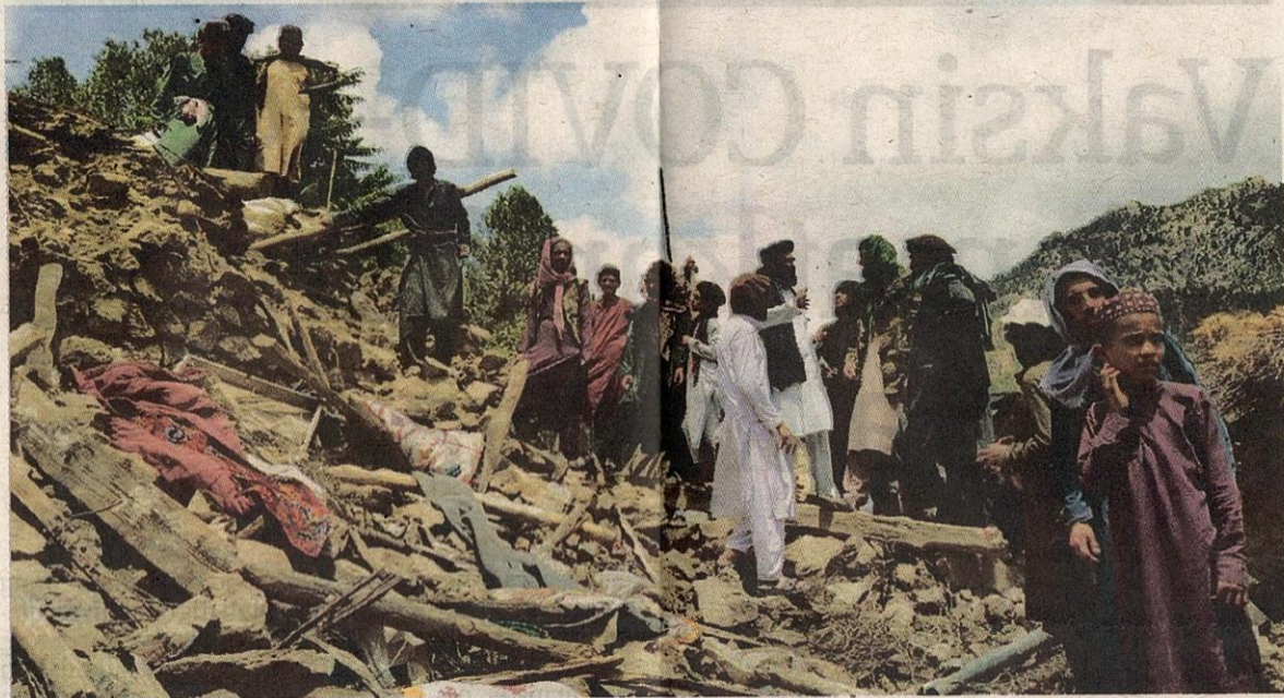
Penduduk kampung membantu operasi mencari dan menyelamatkan dengan menyelongkar serpihan bangunan yang musnah akibat gempa bumi 6.1 magnitud di Paktika.
